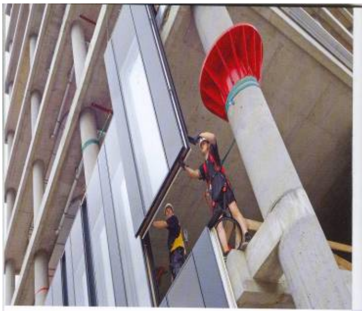
Слика 4. Пример постављања соларних панела као фасадних елемената
